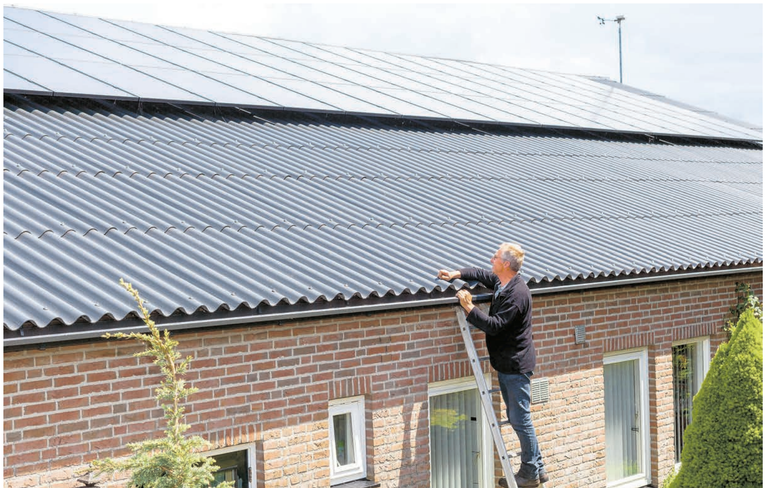
Boomkweker Peter Schrauwen ruilde de asbestplaten van zijn werkloods in voor zonnepanelen.
